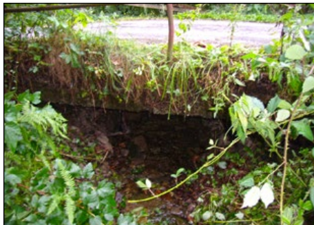
Most před opravou – pohled z návodní strany
