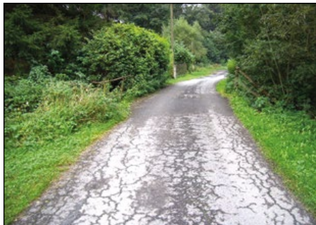
Most před opravou
