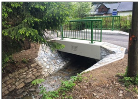
Most po opravě – pohled z návodní strany
