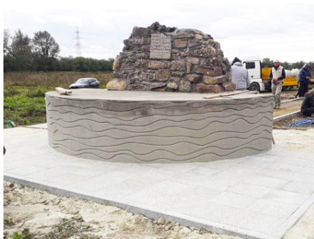
Stavební práce na mohyle u Starého Martinova
